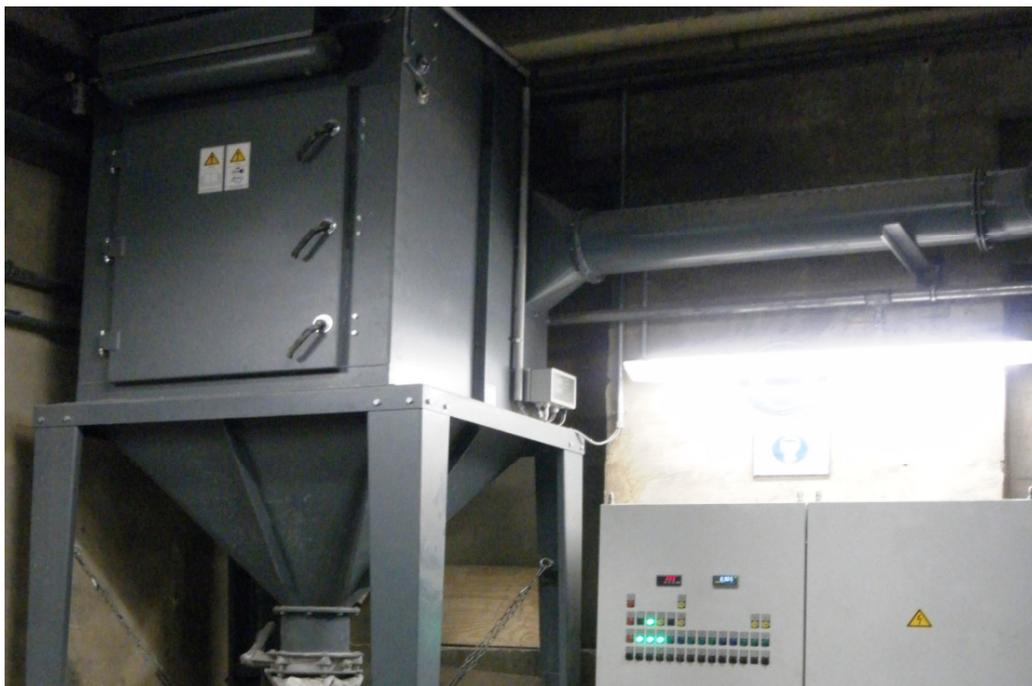
Abb. 10 Entstaubungsanlage
